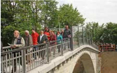
Die Brücke steht wieder: erste Brücken-Wallfahrt
